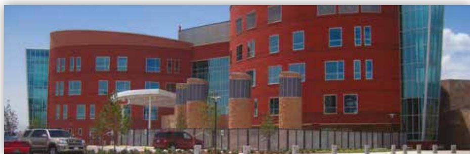
MEMORIAL HEALTH SYSTEM, КОЛОРАДО-СПРИНГС, ШТАТ КОЛОРАДО, США СИСТЕМНЫЙ ИНТЕГРАТОР: TECHNOLOGY PLUS ИНСТАЛЛЯТОР: BEACON COMMUNICATIONS
